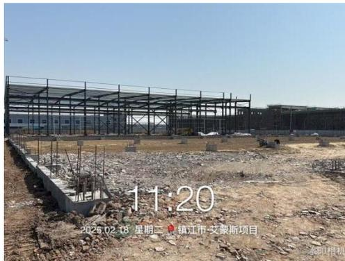
**现场情况：**该项目未开工，已完成项目基础建设，目前正在回填道砟。
