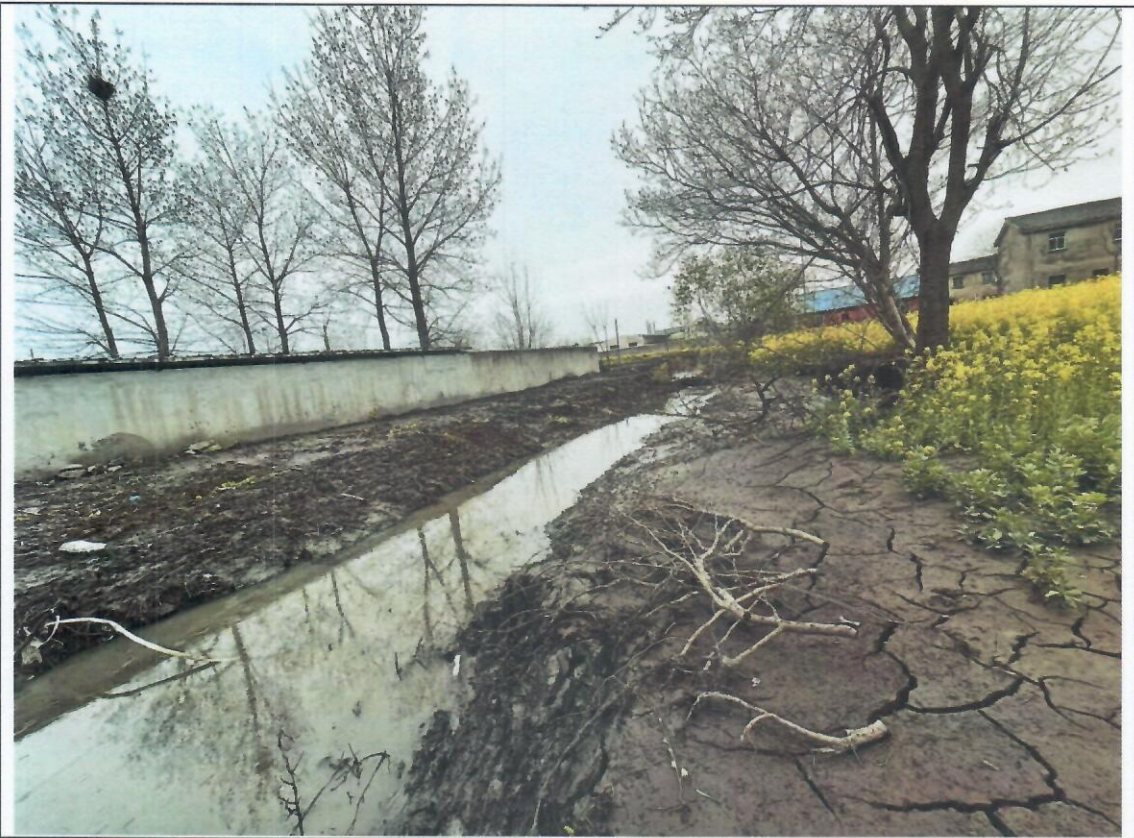
河道疏浚整治，已完成
